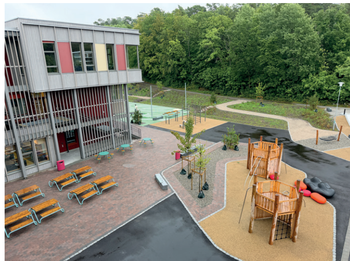
Uteområdet er opparbeidet med blant annet flerbruksbane.
